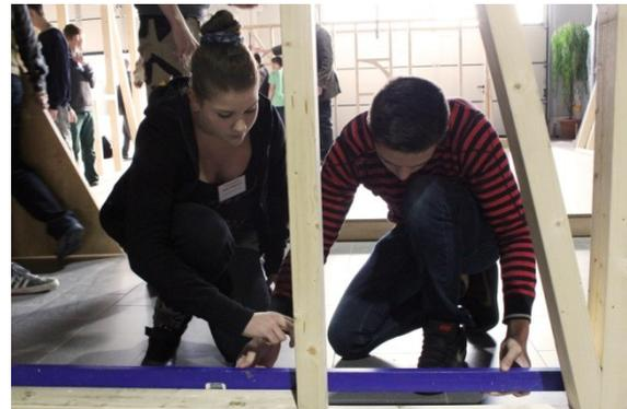
*Nicht nur die Fußbodenplatten mussten an ihren richtigen Platz – mit Hilfe der Wasserwaage zeichneten die Teilnehmer und Teilnehmerin die korrekten Abstände für die Rigipsplatten ein.*
